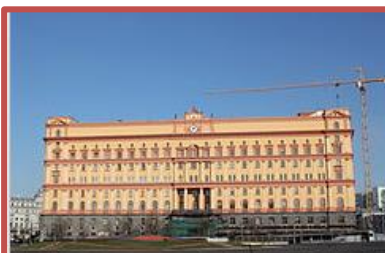
Здание НКВД. Современный вид после реконструкций 1940-х (при Щусеве) и 1980-х годов.
